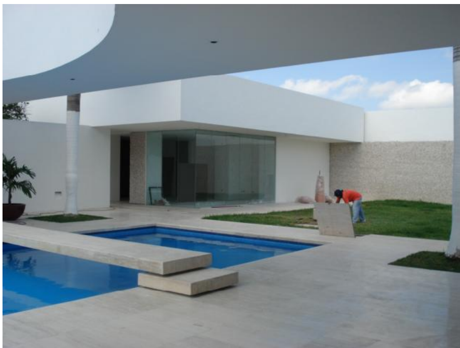
Ampliacion Residencia Crehueras-Vera 2008
